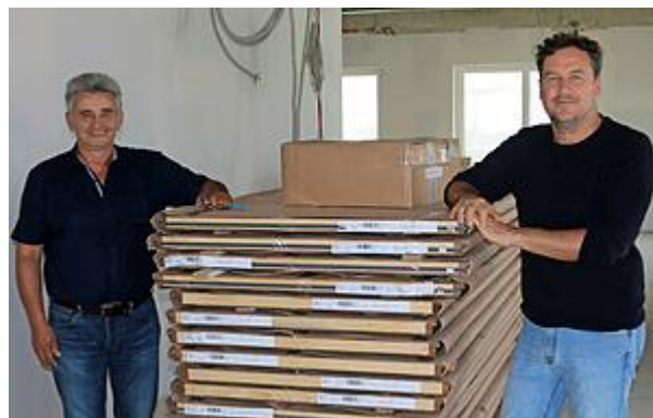
Froh, dass der Zeitplan eingehalten werden kann: Bauleiter Igor Hess (l.) und Christian von Stetten am gerade gelieferten Stapel Türen.
